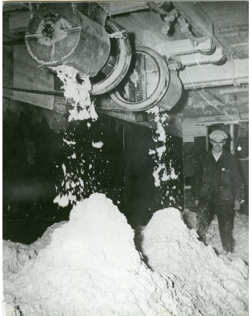
Fig. 2 et 3 Ensachage d'amiante, années 1930.
